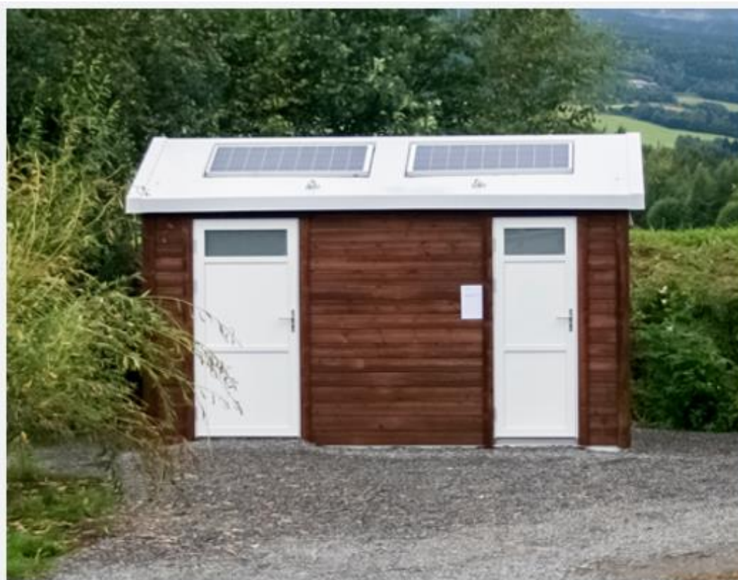
Figur 1.5. Eksempel på en solcelledrevet toiletbygning af en konstruktion, som kunne tænkes anvendt på rastepladser på vejen fra Kangerlussuaq til Kangerluarsuk Tulleq.
