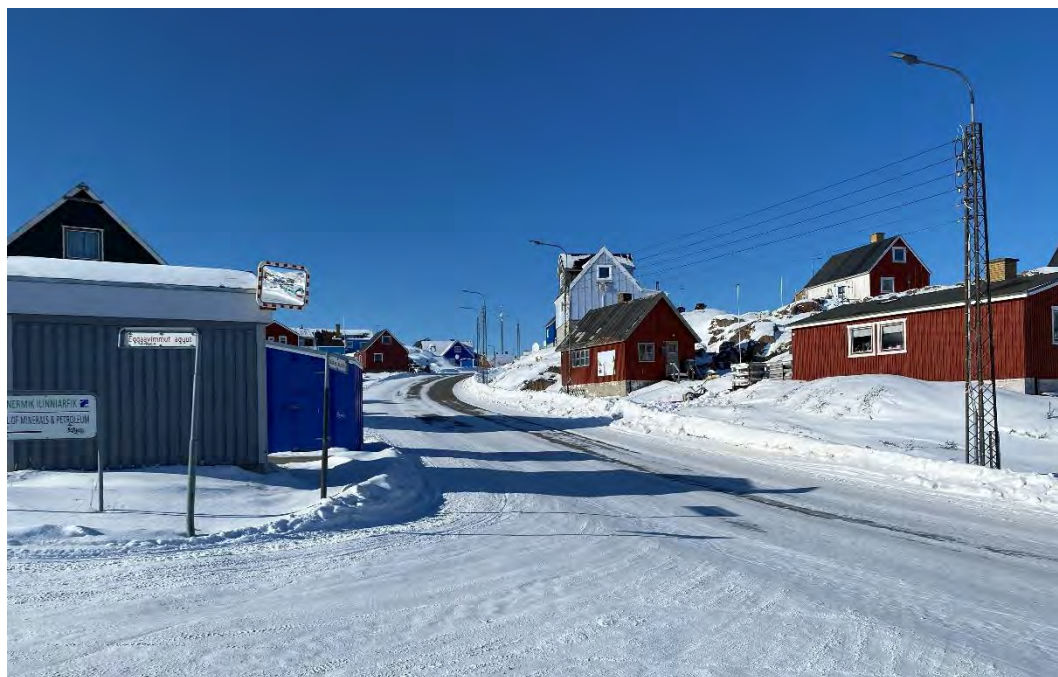
Foto 60: Oversigtsforhold er reduceret fra Eqqaavimmut Aqut til venstre mod Kaalikassaap Aqq. pga. den blå bygning. Den blå bygning betyder at man skal helt hen til vigelinjen før oversigtsforholdene er acceptable. Vejens kurvede forløb er ikke optimalt men acceptabelt.
