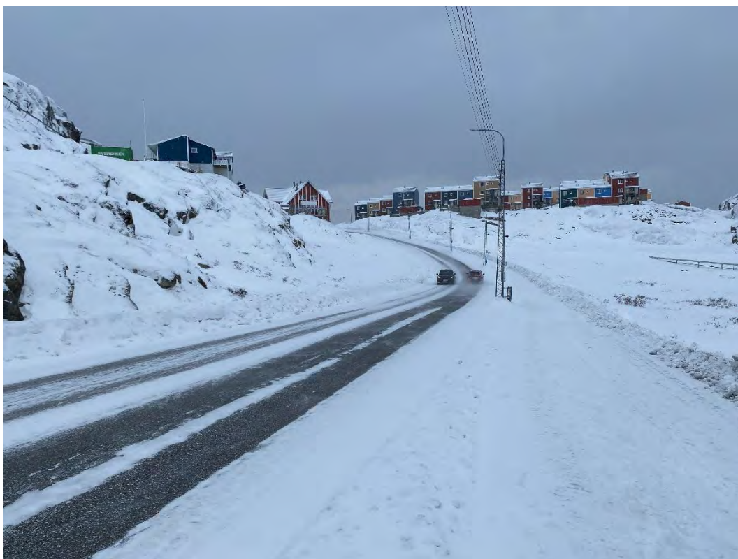
Foto 95: På den vestlige del af Nikkorsuit er der etableret gode forhold for fodgængere i form af en separat sti, som er adskilt fra kørebanen med en skillerabat. Dette princip bør tilstræbes etableret på hele strækningen.
