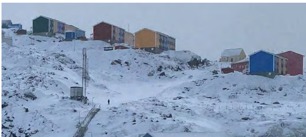
Foto 87: Trappe med stiforbindelse over fjeldet. Den kan med fordel forlænges som trappe og gangbro til Christian 28-ip Aqq. og Larsikkut Aqq. så stiforbindelsen bliver mere tilgængelig hele året.
