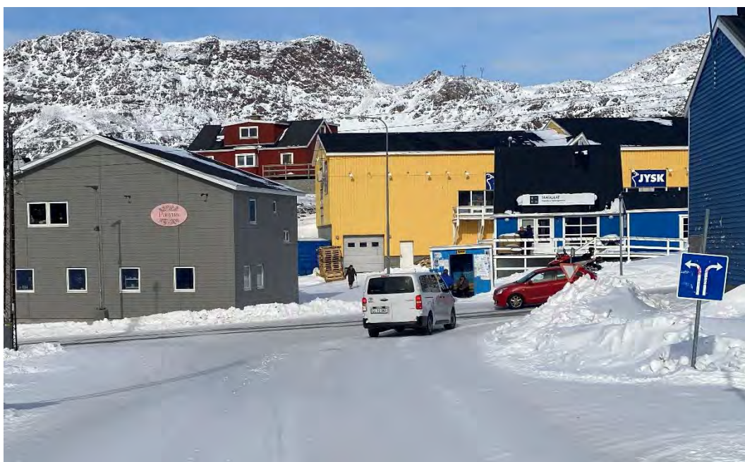
Foto 16: Eksempel på et vigepligtsreguleret T-kryds i Sisimiut, hvor vigepligten er markeret med en B11-tavle. Bemærk anvendelsen af den blå færdselstavle E 15 Vognbaner ved kryds – den frarådes i vigepligtsregulerede kryds.
