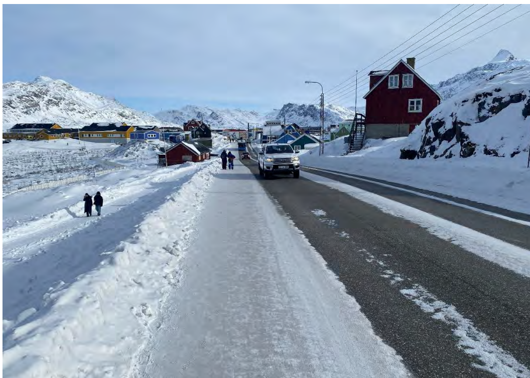
Foto 73: Sti langs Aqqusinersuaq. Det er tydeligt for lokale at der er en sti. Afgrænsningen ud mod kørebanen er udflydende, hvilket ikke er trygt. Der er plads til en skillerabat mellem kørebanen og vejen – men det vil kræve en del terrænregulering.
