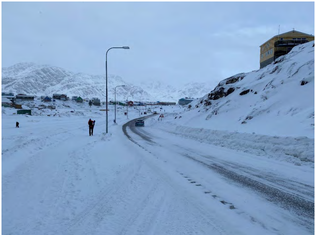
Foto 91: Der er etableret stier langs Adammip Aqq., der er adskilt fra kørebanen med en skillerabat, hvor der samtidig er placeret belysning. Dette er en rigtig god løsning, som tilstræbes etableret langs de øvrige trafikveje i Sisimiut.
