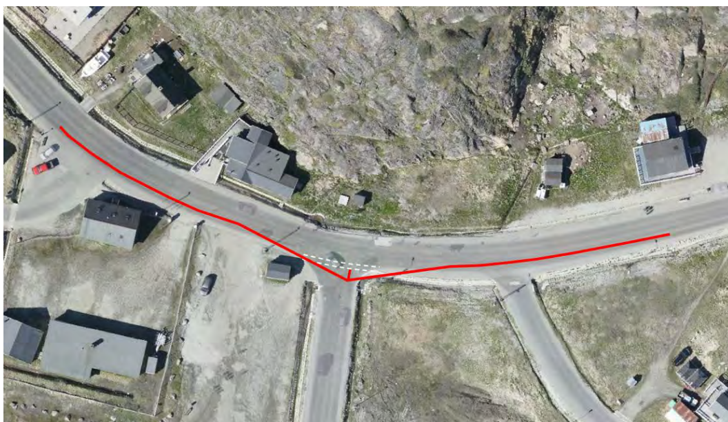
Figur 43: Anbefalet oversigtsareal på 75 m ved 40 km/h fra Glahnip Aqq. mod Aqqusinersuaq. Man kan fint se forbi den grå bygning når man holder ved vigelinjen.
