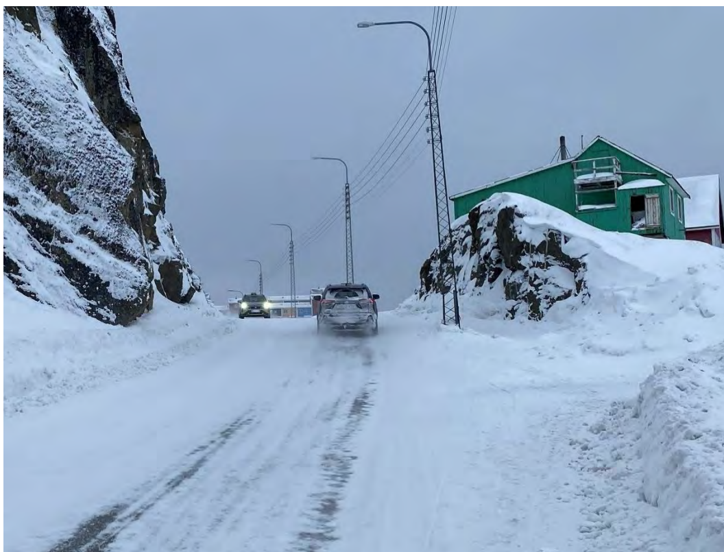
Foto 94: Midt på Nikkorsuit udvides rabatten, hvilket giver begrænset plads til fodgængere. Ved at sprænge fjeld bag belysningsmasterne ind mod den grønne bygning kan der skabes bedre plads til etablering af en egentlig sti.
