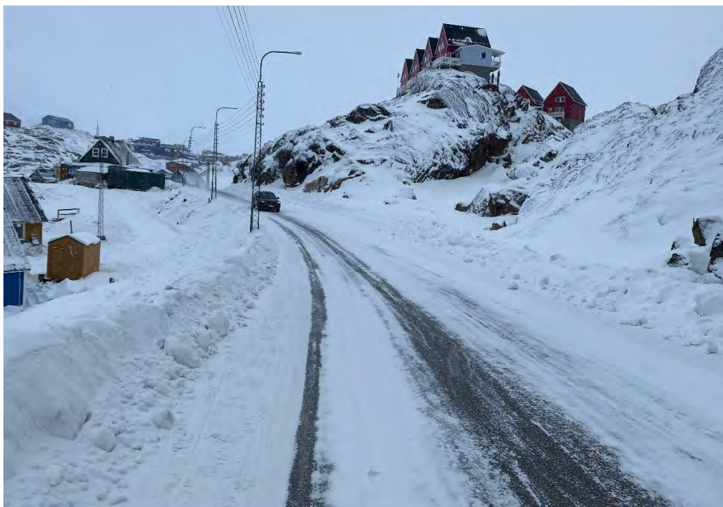
Foto 93: I den østlige del af Nikkorsuit er vejen smal og kuperet, og der mangler trygge faciliteter for fodgængere. Store terrænforskelle gør det vanskeligt at udvide vejen med en sti langs nordsiden (til venstre på fotoet). Ved sprængning af fjeld langs sydsiden kan der derimod blive plads til en sti.
