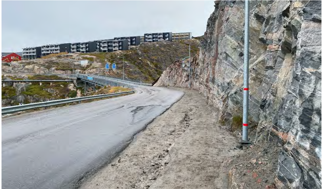
Foto 23: Eksempel fra Ilulissat hvor der på vejen færdes ca. 4.000 køretøjer på et hverdagsdøgn og en del fodgængere. Der er sprængt fjeld væk for at kunne få plads til en bred rabat/sti. Samtidig er der opsat nye belysningsmaster som er trukket helt tilbage i bagkanten af rabatten/stien. Belægningen af rabatten/stien kan med fordel forbedres.
