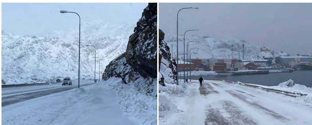
Foto 82: Sti langs Asummiunut ophører og fodgængere ledes ud på kørebanen. Stien bør fortsættes til T-kryds Emiliap Aqq. ved at sprænge noget fjeld (tæt på boliger) og få plads til en sti bagved belysningsmaster eller forsætte hele vejen mod vest.
