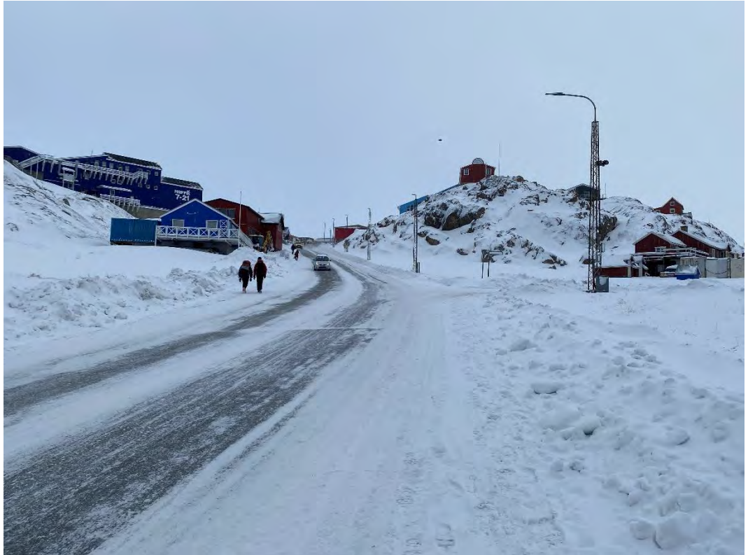
Foto 77: Det er vanskeligt at vide hvilken side fodgængere skal færdes.
