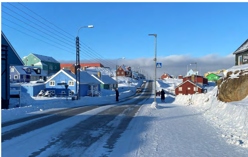
Foto 74: Belysning af fodgængerfelt med gult blink. Det anbefales at fremhæve fodgængerkrydsningen ved at have gult blink og tavle med fodgængerkrydsning i begge vejsider. Det er godt at der er belysning i begge vejsider så krydsningspunktet med belysningsmaster er adskilt fra den øvrige del af vejen.
