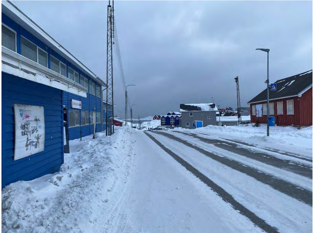
Foto 75: Fodgængerfeltet skal have stiftorbindelser på begge sider så det kan anvendes uden at fodgængere skal gå på kørebanen. Det bør overvejes om fodgængerfeltet kan placeres et mere hensigtsmæssigt sted samtidigt med at der tages hensyn til synligheden som følge af bakketoppen. Dette kan med fordel kunne indgå i en samlet stiplan for byen. Det anbefales at fremhæve fodgængerkrydsningen ved at have gult blink og tavle med fodgængerkrydsning i begge vejsider.
