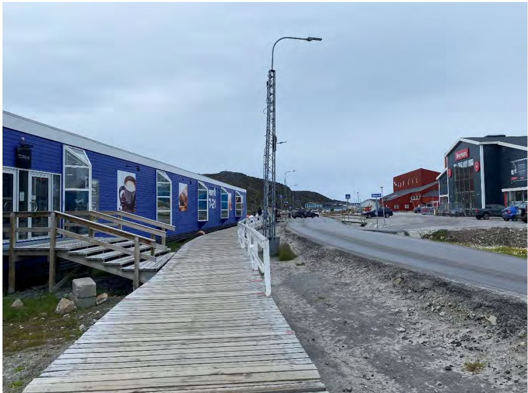
Foto 22: Eksempel fra Ilulissat med gangbro i rabat samtidig med afvanding i grøft.
