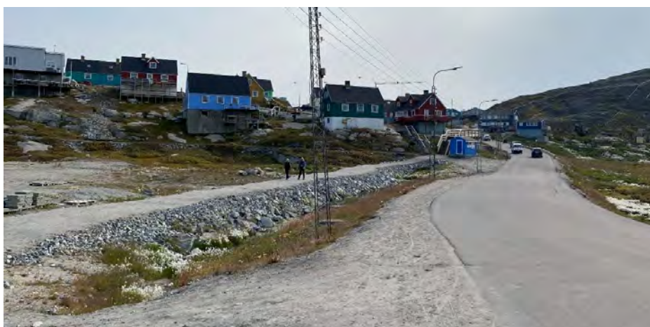
Foto 72: Eksempel fra Ilulissat, hvor der er anlagt en ny sti lidt væk fra selve bilvejen for at undgå dyre ombygninger af den eksisterende vej.
