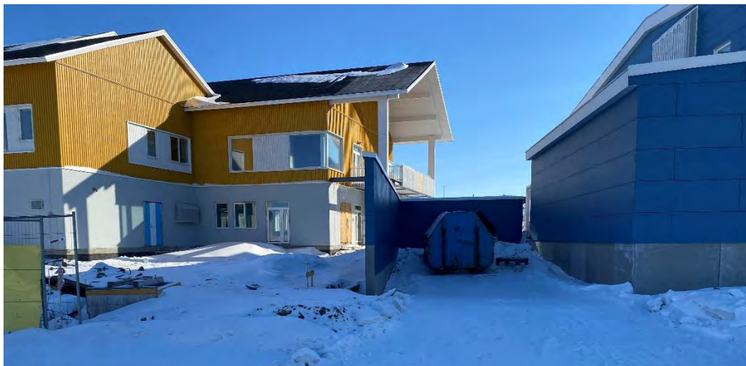
Foto 56: Ved en ensretning af Dorthe Lennertip Aqq. skal udkørsel ske via en vej igennem den nuværende varegård til Deichmannip Aqq. Passagen kan formentlig fortsat anvendes til varegård – men afskærmning og affaldscontainer bør fjernes/flyttes.
