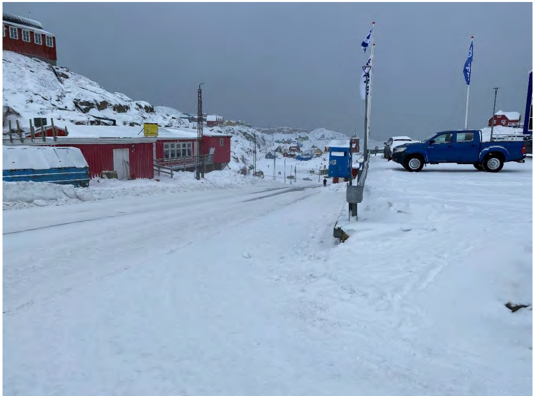
Foto 40: Oversigtsforhold er acceptable fra Kaaleeqqap Aqq. til højre mod Aqqusinersuaq vest. Affaldsbeholder opsat på autoværnet generer ikke direkte i forhold til oversigten når man holder helt fremme ved vigelinjen. Men den kunne alligevel med fordel placeres et andet sted hvor den ikke kan genere.
