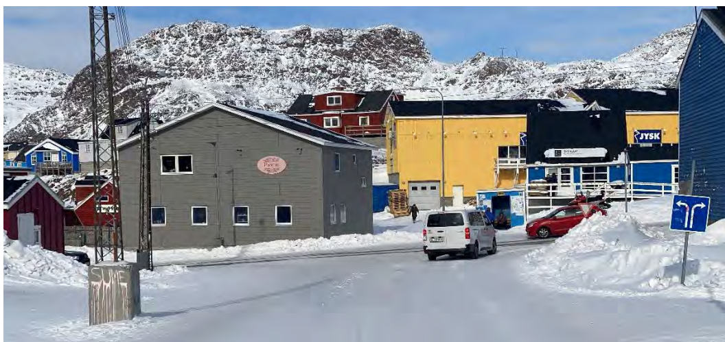
Foto 44: Ubetinget vigepligt fra Guutaap Aqq. mod Aqqusinersuaq. Bemærk anvendelsen af den blå færdselstavle E 15 Vognbaner i kryds frarådes i vigepligtsregulerede kryds, da den kan opfordre til at to biler holder ved siden af hinanden i krydset. Der ligger et busstoppested i krydset på modsatte side af Guutaap Aqq.
