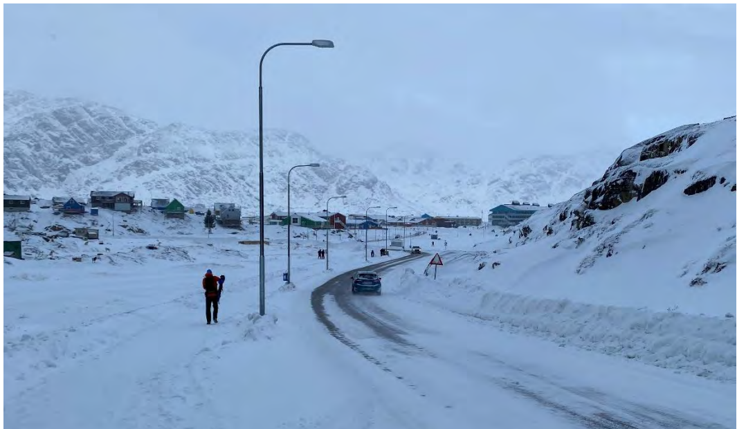
Foto 8: Primær trafikvej hvor der er etableret en sti langs vej vejen (Adammip Aqq.).
