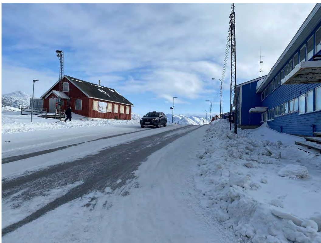
Foto 46: Oversigtsforhold er reduceret fra Guutaap Aqq. til højre mod Aqqusinersuaq øst som følge af bakketop.
