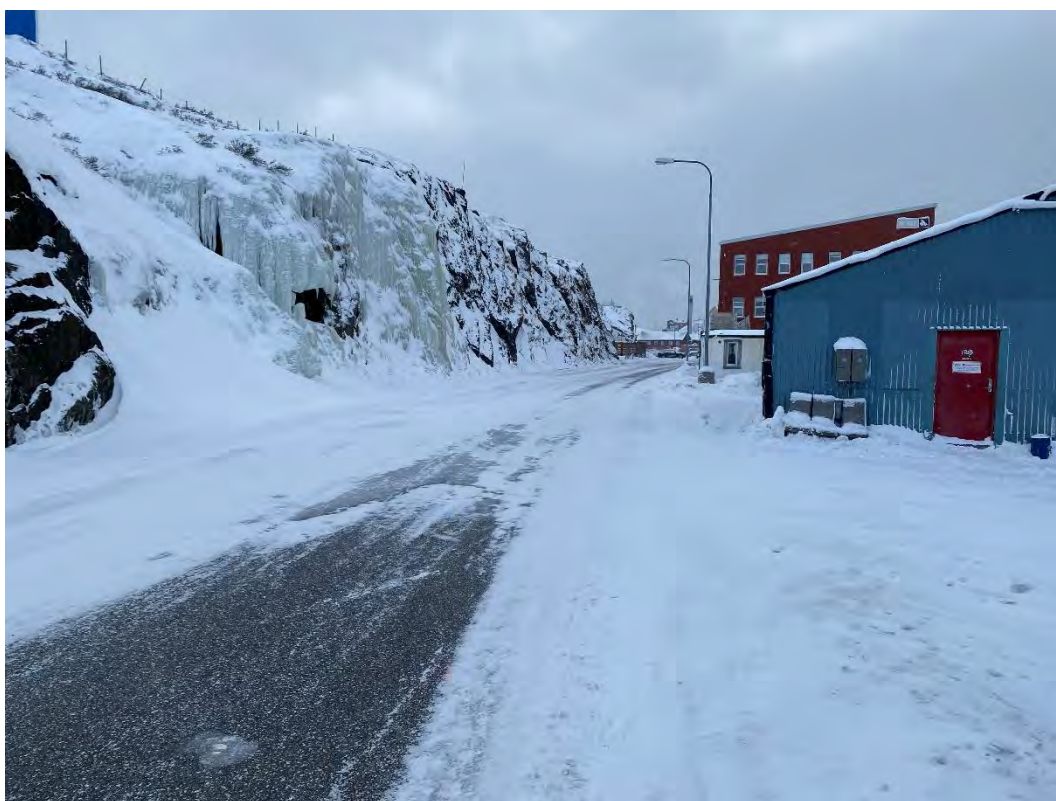
Foto 85: Muunup Aqq. vest for Asummiunut er der istapper fra fjeldsiden og is på vejen. I dag passer trafikanterne nogenlunde på hinanden og kører på skift nogle steder, men det vil blive svært, når trafikken bliver større i takt med udbygningen af Akia. Bedre afvanding til grøft kan være med til at mindske problemet.
