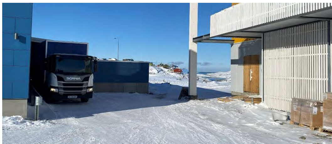
Foto 54: Ved en ensretning af Dorthe Lennertip Aqq. skal udkørsel ske via en vej igennem den nuværende varegård til Deichmannip Aqq. Passagen kan formentlig fortsat anvendes til varegård – men afskærmning og affaldscontainer bør fjernes/flyttes.
