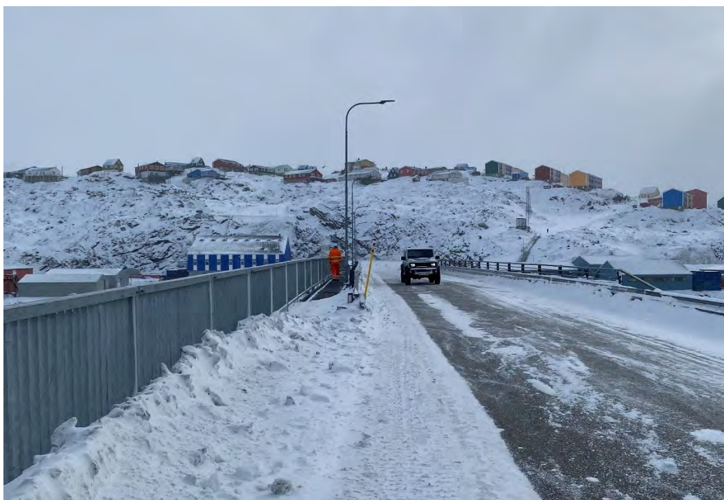
Foto 81: Asummiunut, nord for afslutning af autoværnet på broen er snerydning mangelfuld på strækningen til stien ved Sarsuatsiivinnguup Qulaa.
