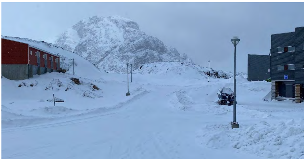
Foto 11: Eksempel på anvendelse af "parkarmaturer" som belysningsmast på boligvej – er med til at signalere at bilisterne skal køre med lav hastighed.
